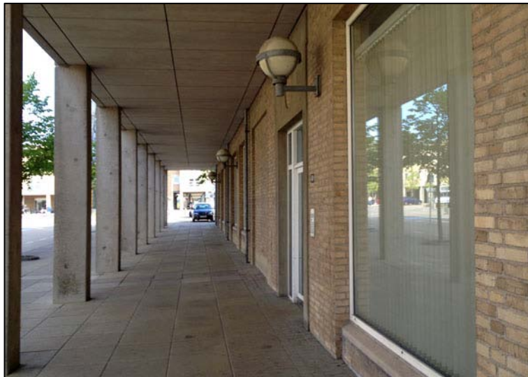
Den eksisterende arkade mellem bebyggelsen og forpladsen ved Høje-Taastrup Boulevard.
